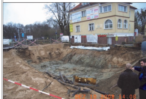
Das Bauloch im Dezember
